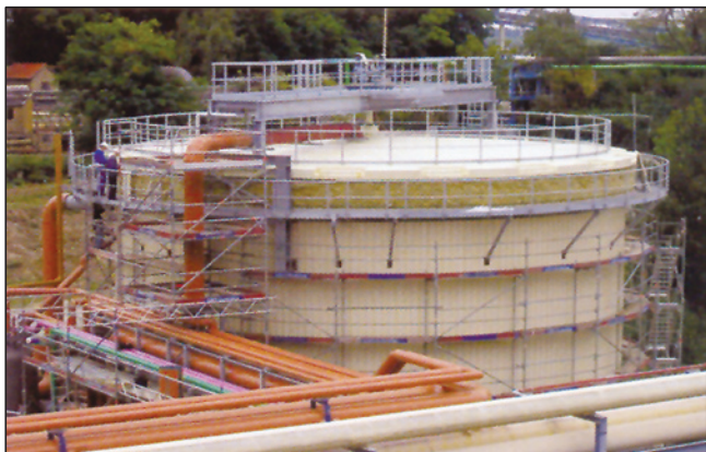
شکل ۱۲: دکانتور تغلیظ‌کننده، تیپ دور - ایور با ظرفیت ۱۶۰۰ مترمکعب
