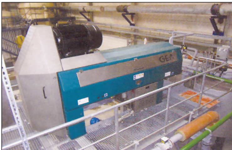
شکل ۱۳: سانتریفوژ دکانتوری GEA و جداکننده
